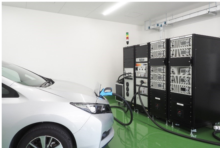
「EV 充電テストラボ」内での測定イメージ
