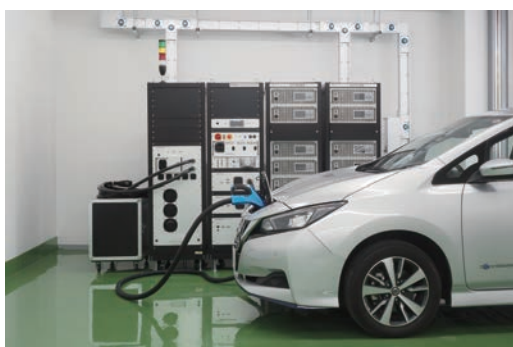
EV 充電テストラボでの EV 充電評価サービス
